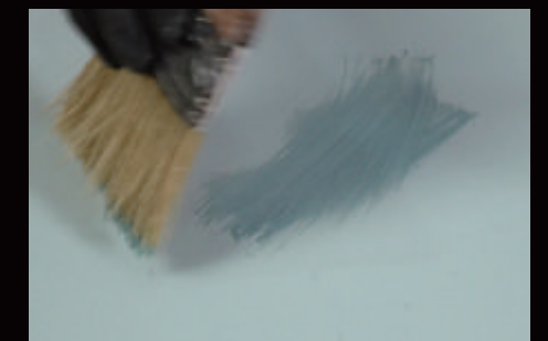
③ 主材不可加入超過5%的水施工, 掃塗2-3次
